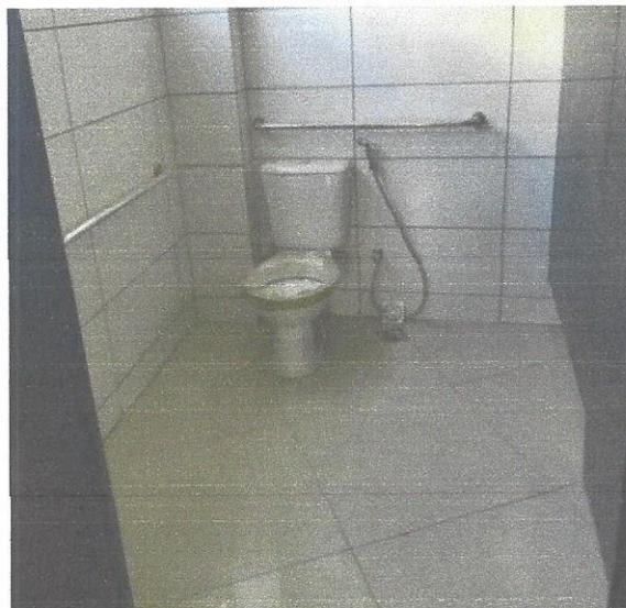
**Figura 10: Banheiro com barras de apoio PNE.**
