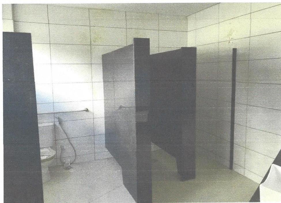
**Figura 06: Divisórias em granito, duchas e barras de apoio.**
