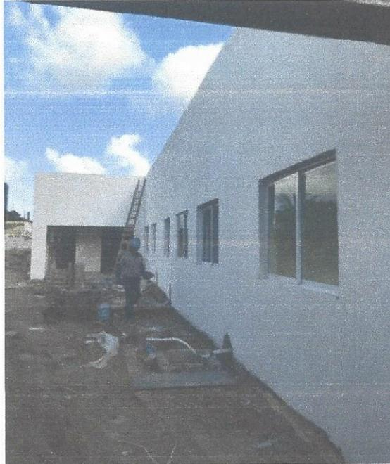
**Figura 09: Fachada externa emassada.**
